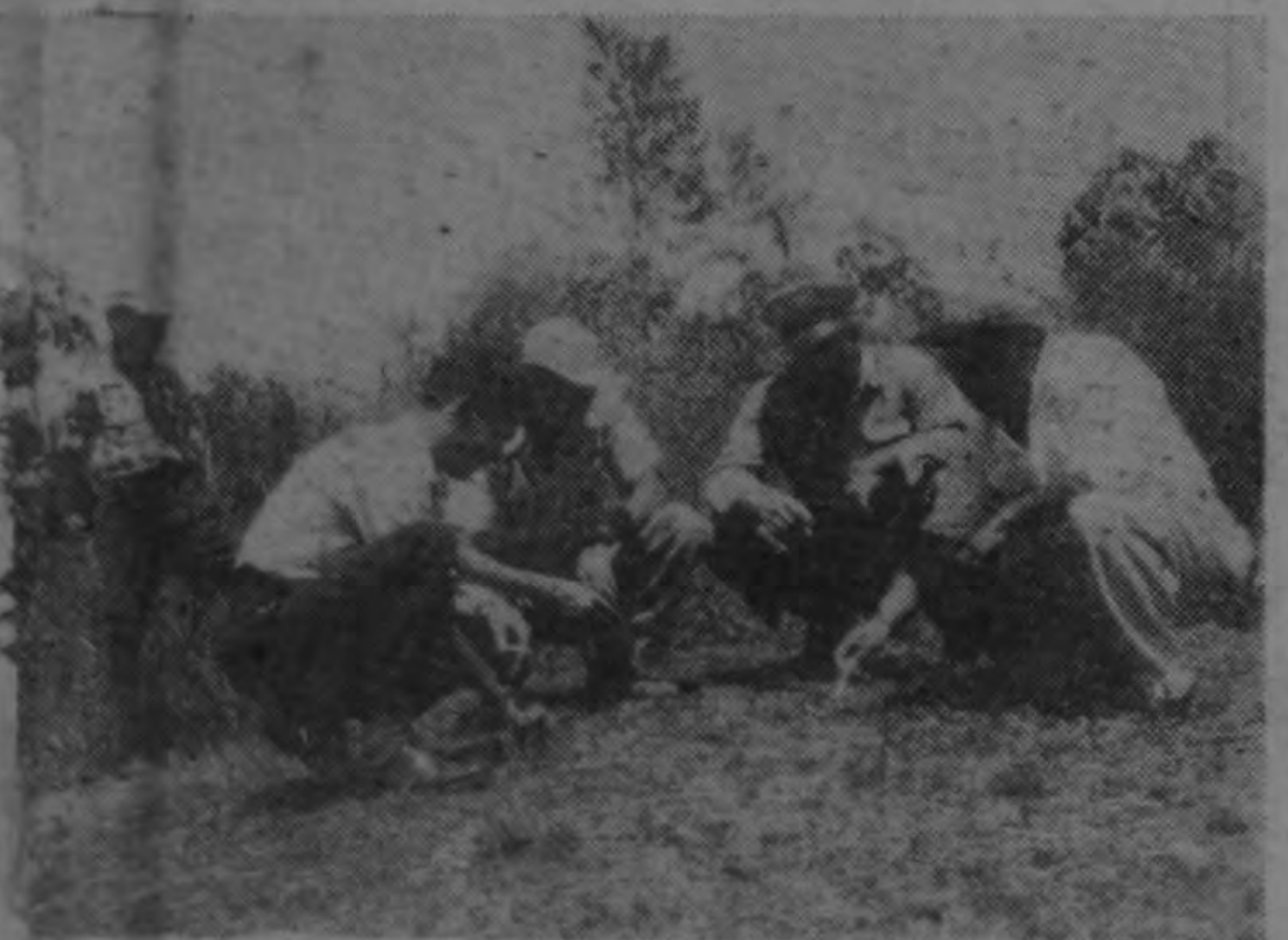
CARRETERA TARRAZU-QUEPOS. —Presentamos tres vistas de la importante obra que se está ejecutando para unir, por moderna vía terrestre, las poblaciones de San Marcos de Tarrazú y Quepos. En primer término, uno de los tramos, a la entrada de Quepos, que permite formarse una idea de la estructura que ha de tener la carretera; en segundo término, un tractor del Ministerio de Obras Públicas, en plena labor; y, finalmente, don Francisco Pineda, de la Municipalidad de Quepos explicando a nuestro redactor Cordero Crocero, sobre el terreno, el curso que seguirá la magnífica arteria que se está construyendo. (Fotos cortesía de don Alvaro Rojas Rojas). Amplia información en página 7.
